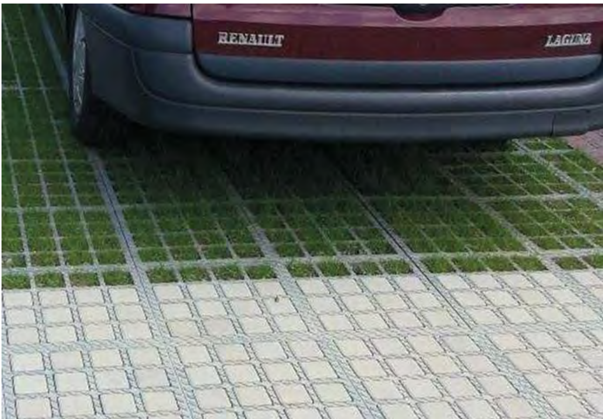
Abbildung 5: Beispiel MultiDrain-PLUS 2000 System, Quelle: www.huebner-lee.de
