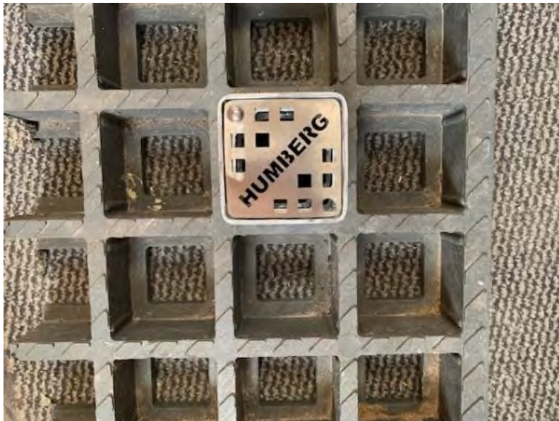
Abbildung 6: Beispiel eines Lüftersteins | Quelle: LSBG
